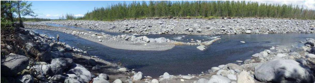
Figure 10 – Enrochements (centre de la photo) disposés sur le répartiteur R04 Grande Tête pour assurer la dérivation du débit vers les canaux rive gauche (Saint André).
