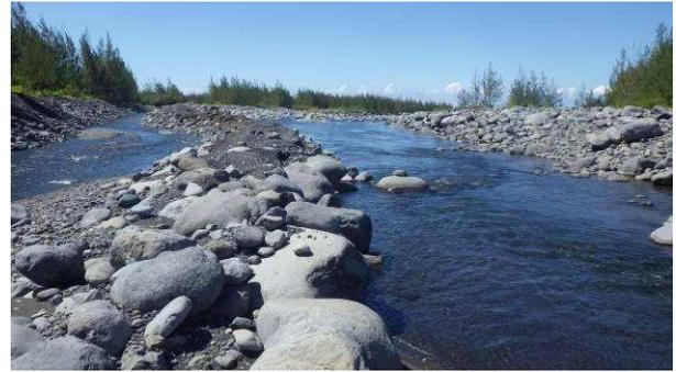
Figure 12 – Exemple d'un répartiteur aménagé (Grande tête) : les remodelages ne constituent pas des surcotes de plus d'1 m et les matériaux restent mobilisable par le cours d'eau en crue.
